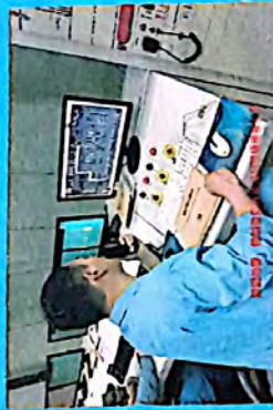
控制室发现泄漏报警，通知现场确认
